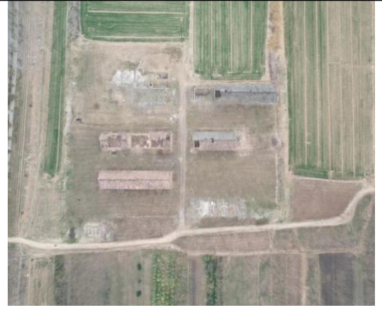
原地下水检测站区域现状
